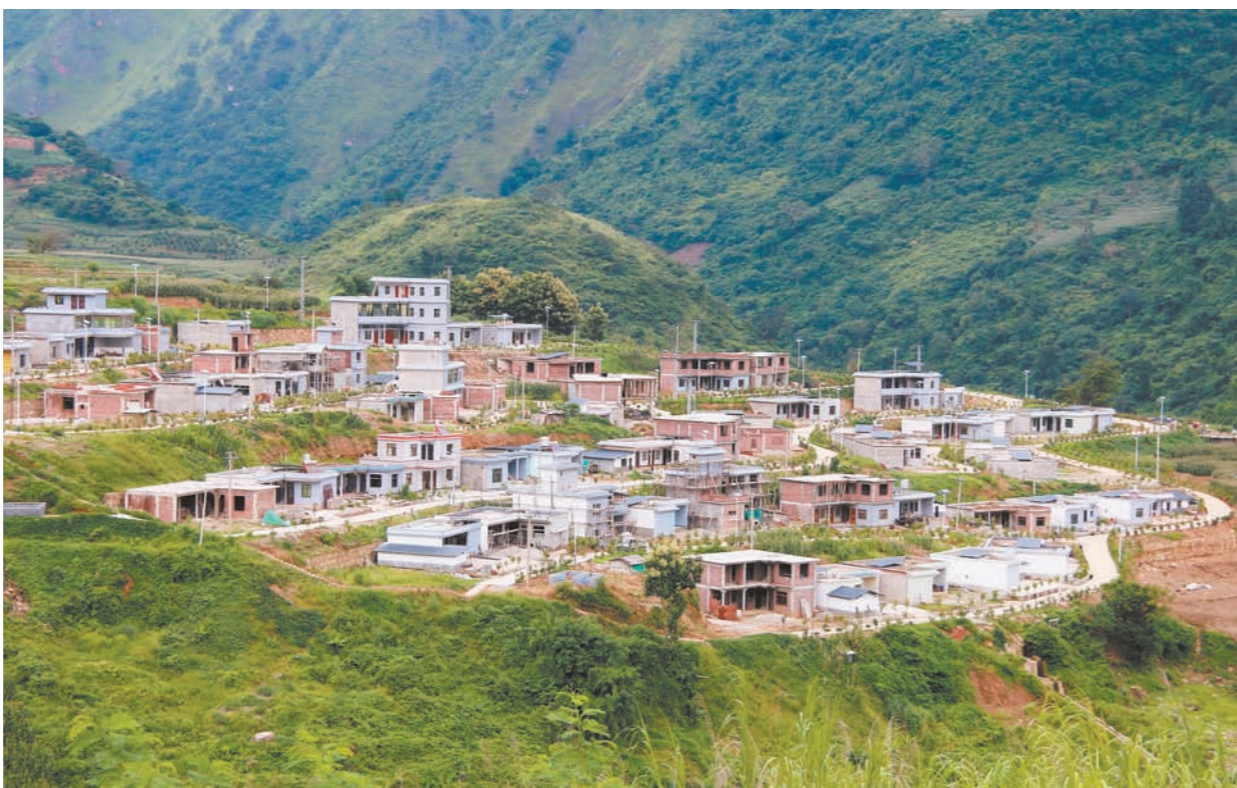
永德县大雪山乡太平掌村在实施忙岗回搬安置点建设中，房屋户型由县级部门统一设计提供选择，村党组织牵头组建建房理事会，由理事会统一采购钢筋、水泥、砖等建房材料，切实做到党员带头建房、发挥示范，带头互帮互助、降低建房成本，带领群众加快推进基础设施建设。
