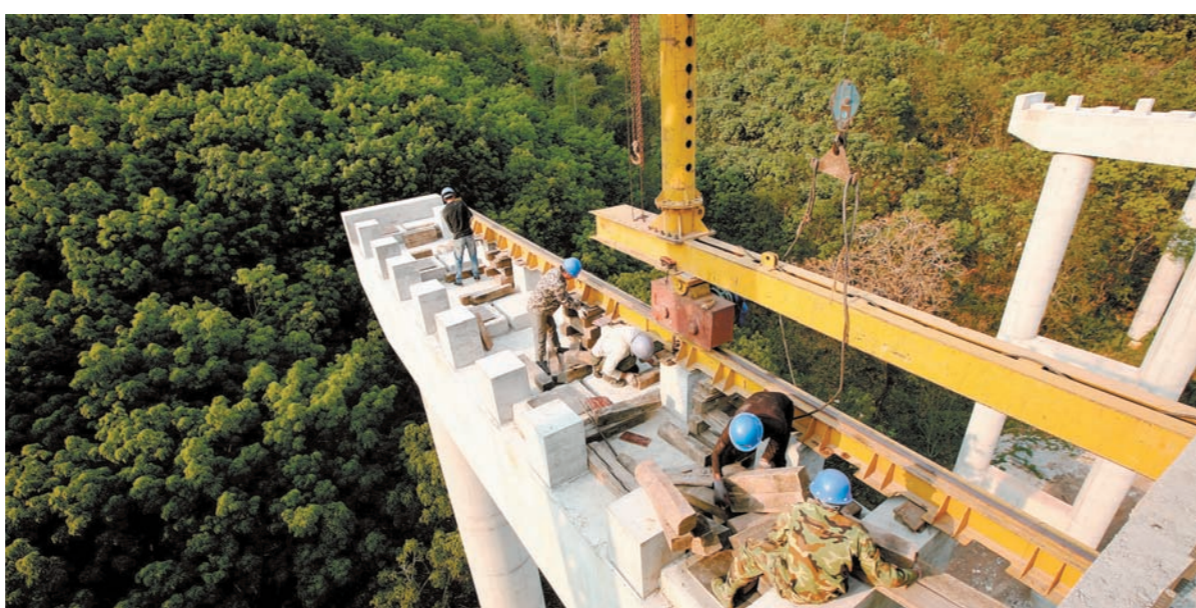
临清高速公路全长 153.6 公里,设计时速每小时 80 公里,目前,项目建设各项工作加快推进。图为耿马自治县孟定段柏油高架桥施工现场。 杨茂芳 摄
