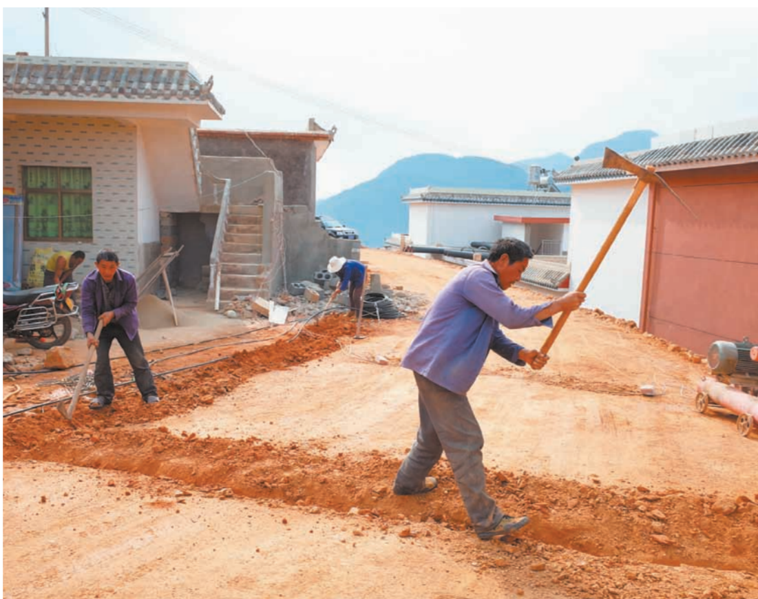
近期,云县大寨镇棠梨坝村在县委宣传部、文广局派出的驻村工作队帮助指导下,对易地扶贫搬迁点鹿子场的搬迁户水、电、路等基础设施建设完善情况进行排查整改。图为群众正在开挖水管线路。
